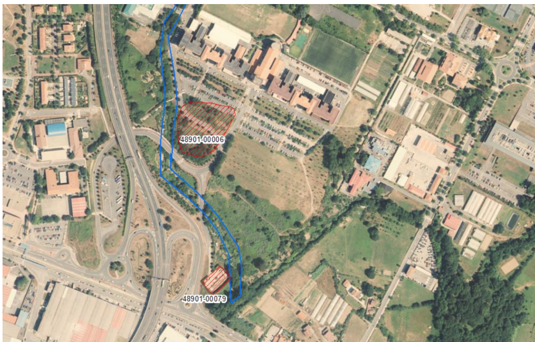
Imagen 15. Parcelas inventariadas como suelos potencialmente contaminados junto al ámbito MN-UN 01 Untza Erreka.
